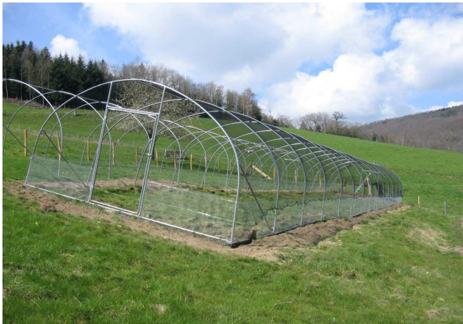
Volières en construction sur le site de Saint-Forgeux
